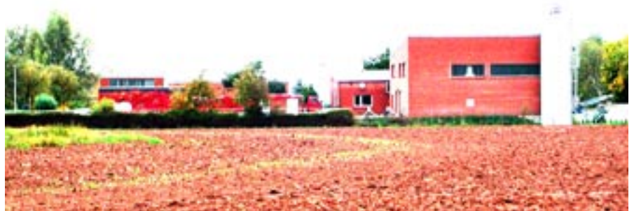
Das Verbandsklärwerk nördlich von Reichensachsen, Richtung Oberhone, an der Wehre gelegen.
